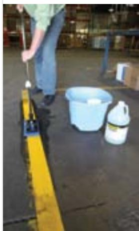
El limpiador DuraStripe puede ser usado eficazmente en maquinas para limpiar pisos, pistolas de presión y limpiadores a vapor. Es una emulsión a base de agua no tóxica, incolora, no inflamable y biodegradable que es perfecta para el mantenimiento de todos los productos DuraStripe.
